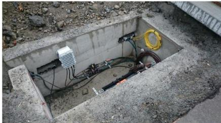
Strassenschacht mit Glasfasern, Kupferkabel und Glasfaser Netzelement
